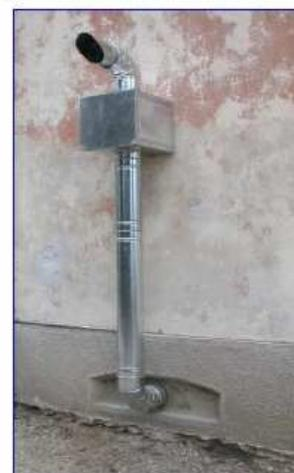
**Figura 47: prevenzione nuova edificazione presenza di murature verticali controterra**
